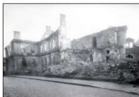
Rue Pasteur côté sud : l'université en ruines
