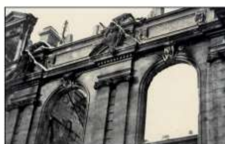
Détail de la façade de la bibliothèque détruite
