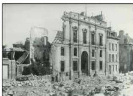
Rue Pasteur côté nord : le Rectorat en ruines
