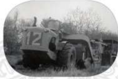
Premiers travaux de défrichage
