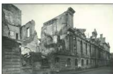
Rue Saint-Sauveur : la bibliothèque en ruines
