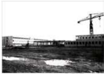
Le chantier de l'IUT en 1969
