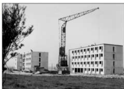
Construction de la cité universitaire (chantier de 1954)
