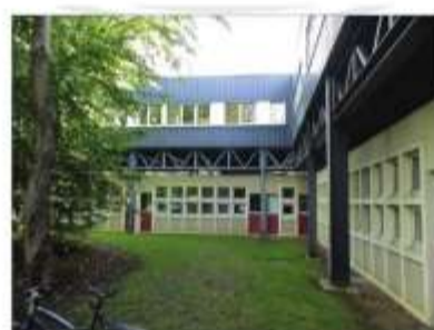
1993 : construction de la 1 re extension du LPC en étage reposant sur des « pilotis » en acier. La 2 e extension en prolongement à droite date de 2000.
